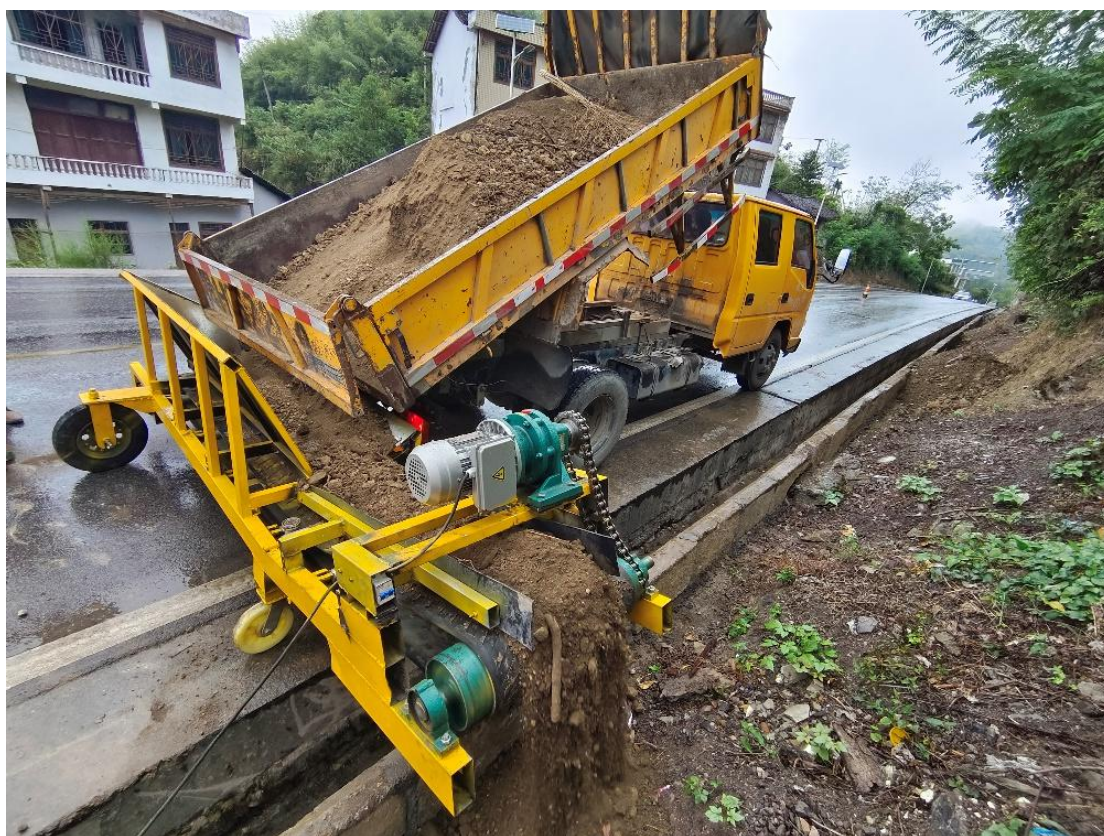
养护生产运输传送装置使用示意图
