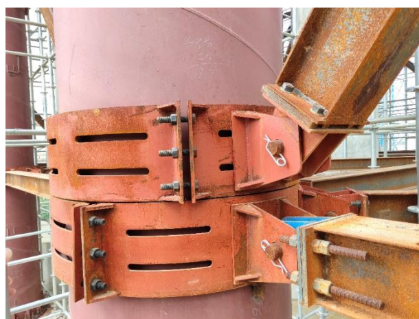
装配式抱箍安装示意图
