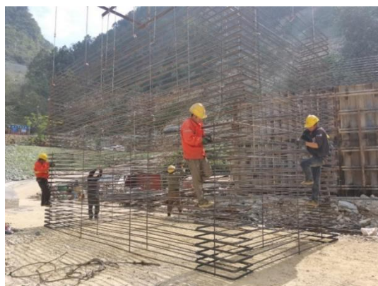
箍筋胎模架上安装示意图 b
