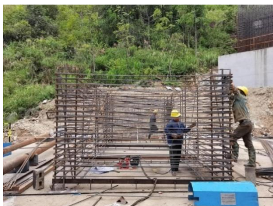
箍筋胎模架上安装示意图 a
